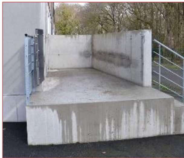
Rysunek 3.4. Betonowe nabrzeże załadunkowe w gospodarstwie, które może uprościć czynności załadunkowe
